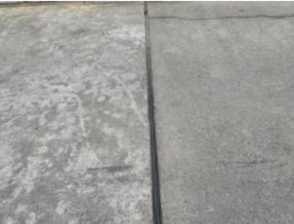
伸缩缝型钢变形
