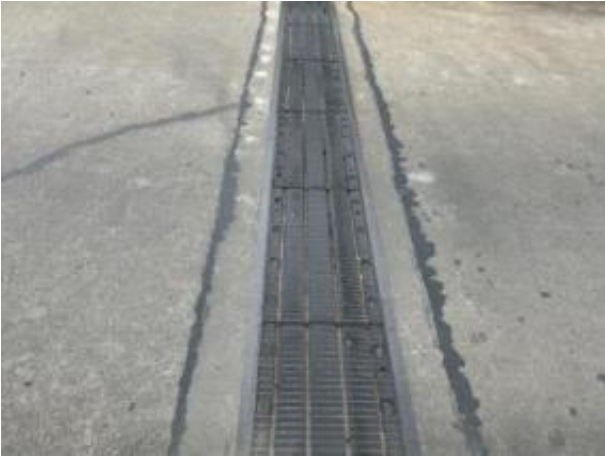
伸缩缝槽口堵塞
