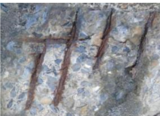
挑梁钢筋锈断
